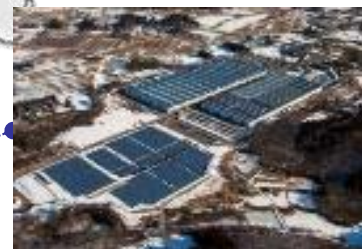
DS仙台港 2.6MW
