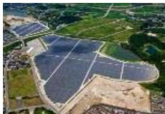
DS福岡宮若 I・II・III 27.2MW
