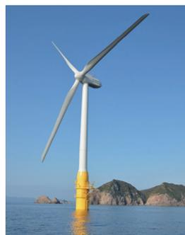
長崎県五島市柁島沖の浮体式洋上風力発電の2メガワット風車
