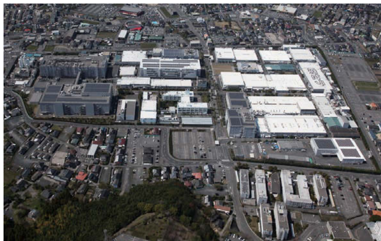
メガソーラー設置によるCO 2 削減
