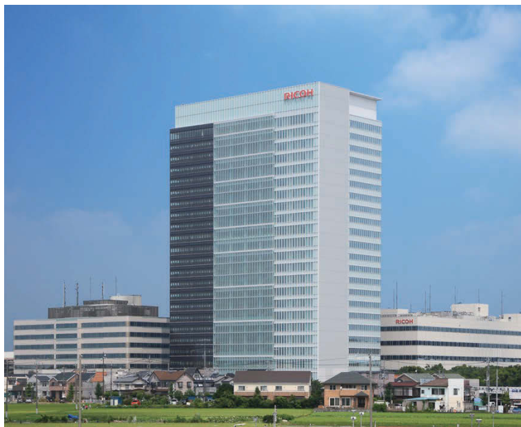
省エネルギー施策実施の建築物
