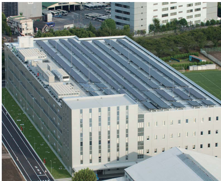
太陽光発電設備の導入
