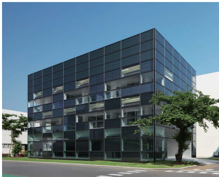
大成建設 ZEB 実証棟
