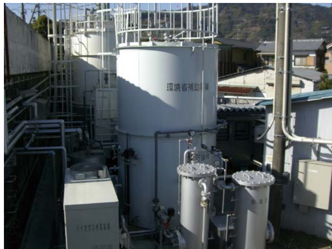
小型メタン発酵システムの外観
