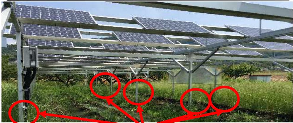
一時転用申請をしたのは、営農を適切に継続しながら上部空間に設置する太陽光発電設備を支える支柱の基礎部分
