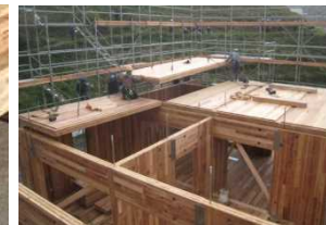
CLTを用いた施工例
