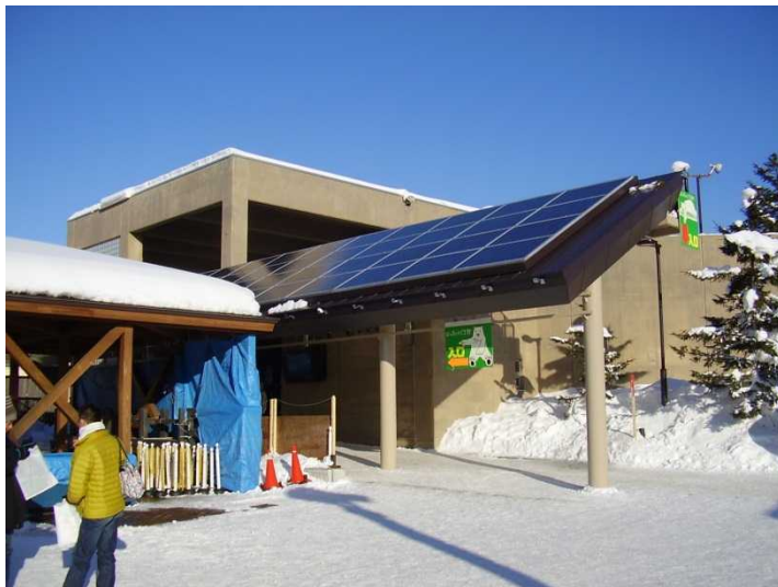
ほっきょくぐま館入り口に太陽光発電設備 (10kW)を設置しています。
