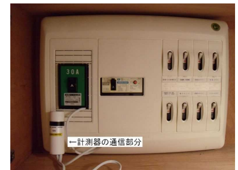
クランプ設置後に分電盤の蓋を閉めた状態
