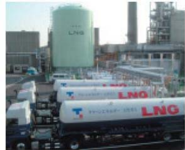
利根川事業所のLNGサテライト基地
