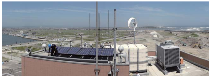
NHKロボットカメラシステム(1kWレンズ風車と1kW太陽光パネル、仙台亘理町、NHK広報部提供)
