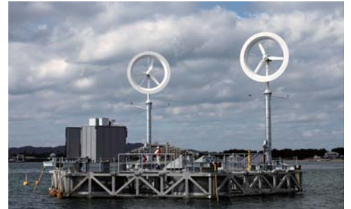
海上浮体式再生可能エネルギーファーム 直径18m六角形浮体、130トン、3kWレンズ風車2基と2kW太陽光パネル
