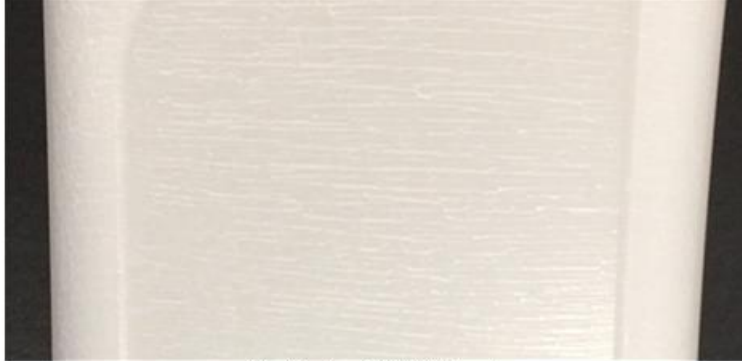
拡大図A:表面クラック
