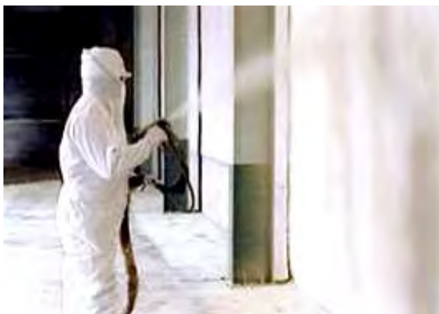
図 5-16 現場施工の硬質ウレタンフォーム施工例
