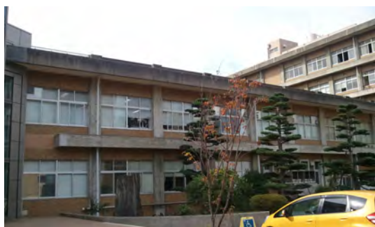
新潟大学工学部 B 棟
