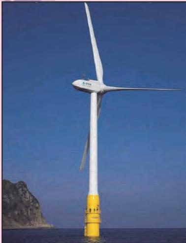
国内初2MW浮体式洋上風力発電機
