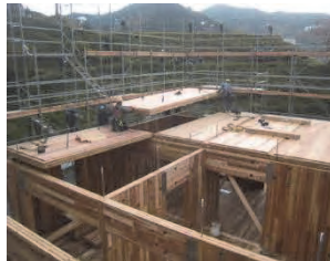
CLTを用いた施工例
