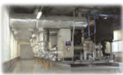
①中央方式冷凍冷蔵機器
