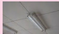
PCB使用照明器具 (蛍光灯の例)
