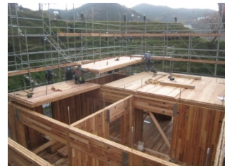
CLTを用いた施工例
