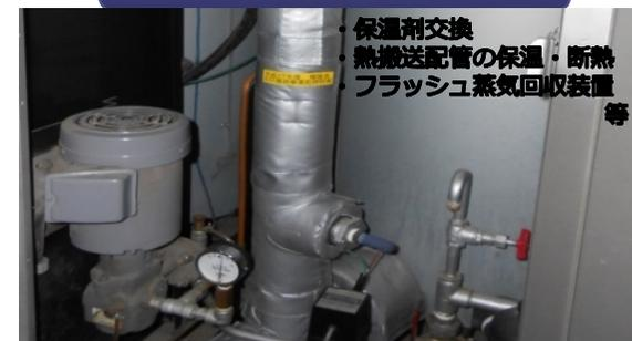
部分的な部品交換・追加により設備の稼働効率を向上させ、導入エネルギーの効率的利用に貢献。
