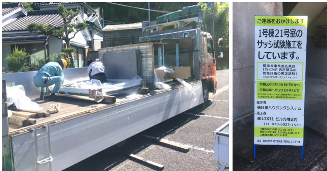
図Ⅱ-1-2-8 CNF 樹脂サッシの搬入状況（2019 年 5 月 21 日）
