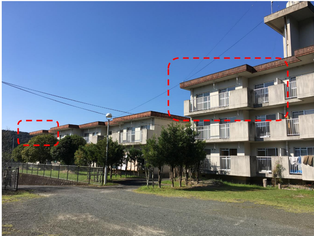
図Ⅱ-4-2-3 実証住宅南側外観
