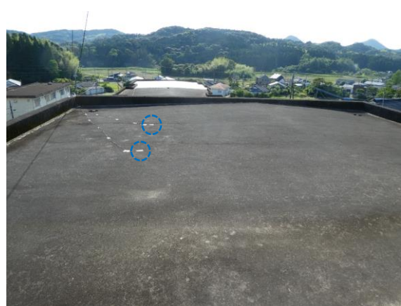
図Ⅱ-4-2-15 屋根表面温度測定と日射計 (左: 1号棟、右: 2号棟)
