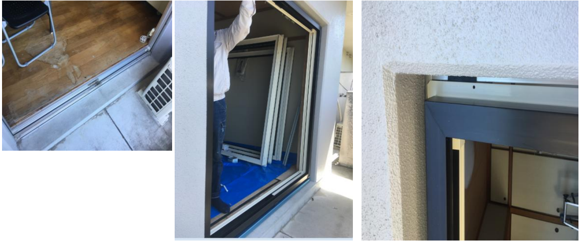
図Ⅱ-1-2-9 既設アルミサッシ枠上への樹脂サッシ枠の取付け（2019年5月21日）
