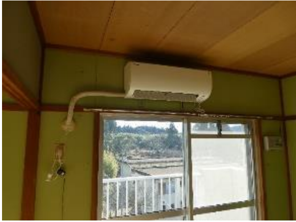
図Ⅱ-4-2-10 エアコン消費電力量計測器設置の様子 (左：エアコンとCT、右：電力量計とパルス測定器)
