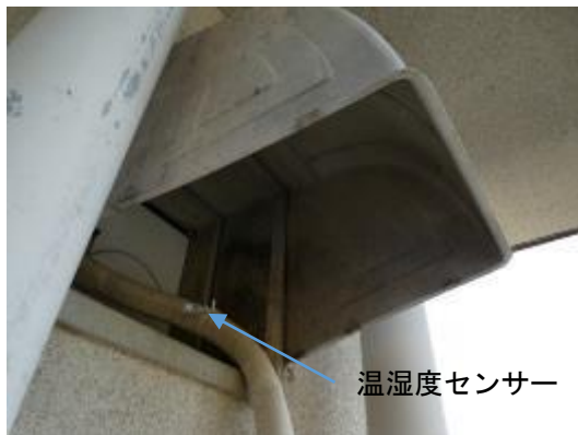
図Ⅱ-4-2-9 計測器設置の様子 (外気温湿度)
