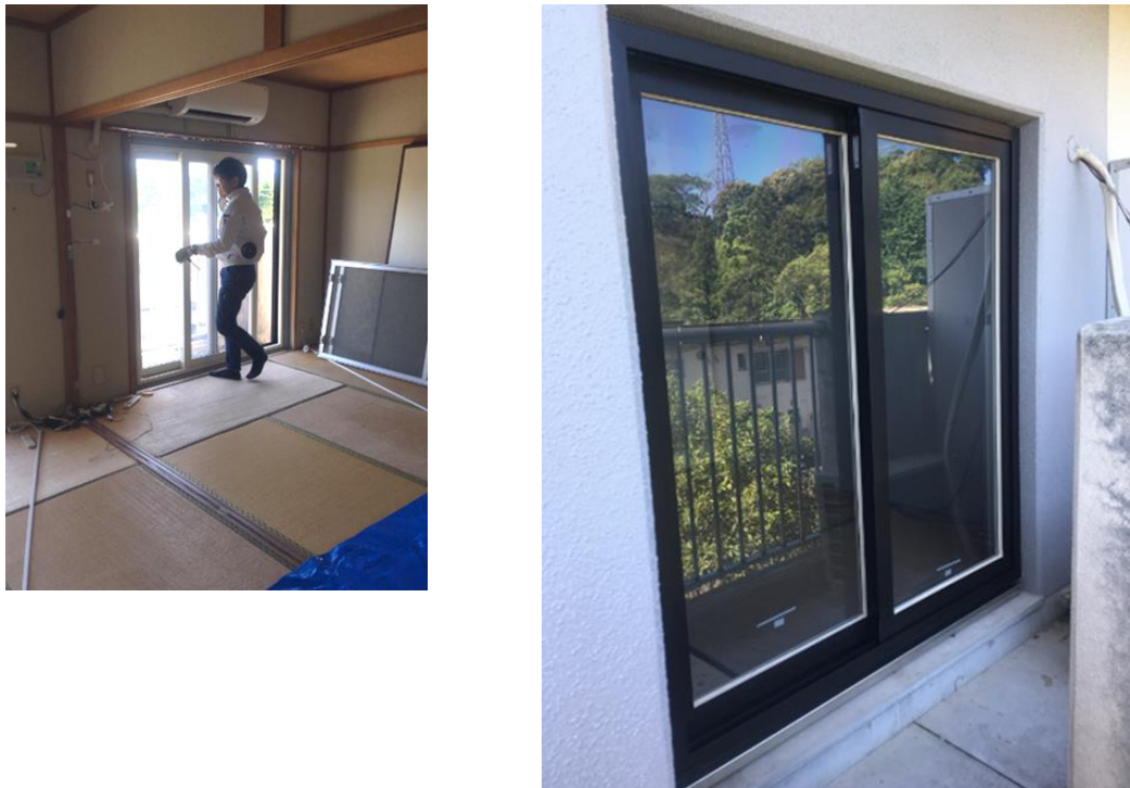
図Ⅱ-1-2-10 樹脂サッシ枠へのCNF樹脂サッシ障子の建込み（2019年5月21日）
