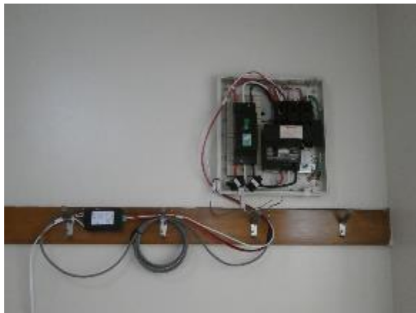
図Ⅱ-4-2-11 住宅全体消費電力量計測器 (左)、データ収集機とWifi ルーター (右)
