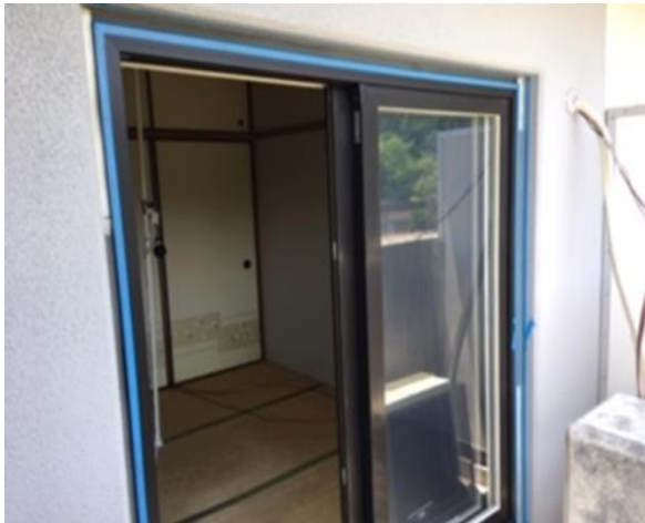
シーリング前
