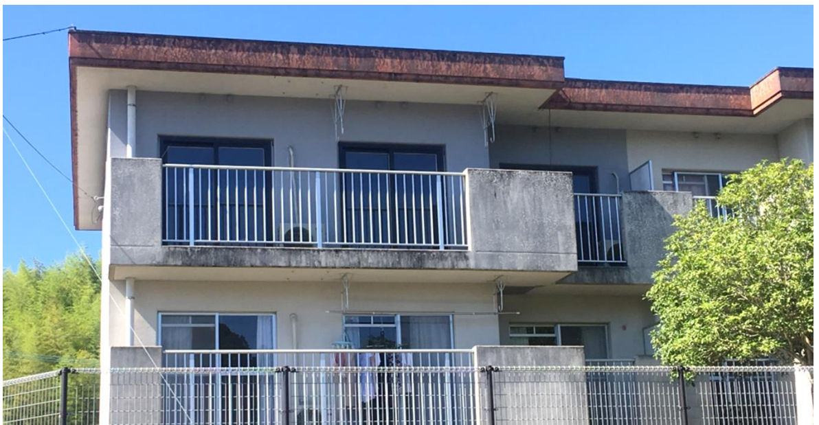
図Ⅱ-1-2-12 CNF樹脂サッシ施工状態（2階住戸部；南面3窓）
