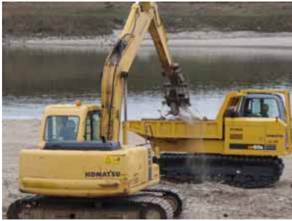
バックホウによる回収（赤川河口部）
