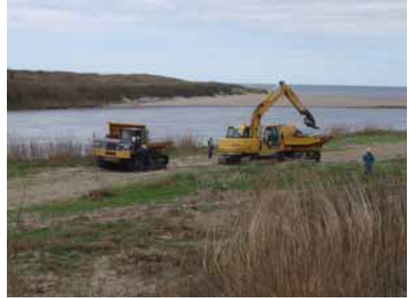
バックホウによる回収（赤川河口部）
