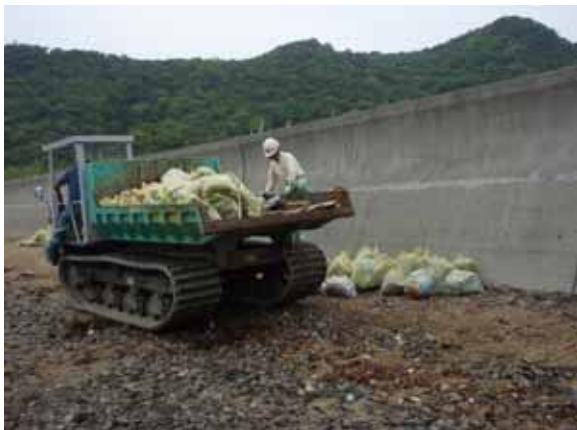
不整地車両による運搬（樋島海岸）
