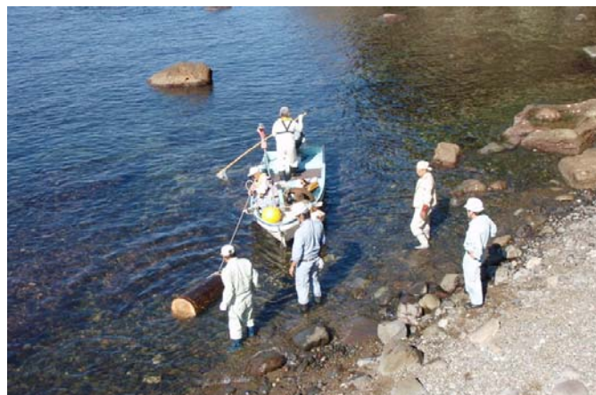
図 3-2 重機搬入困難な礫浜からの流木の搬出
