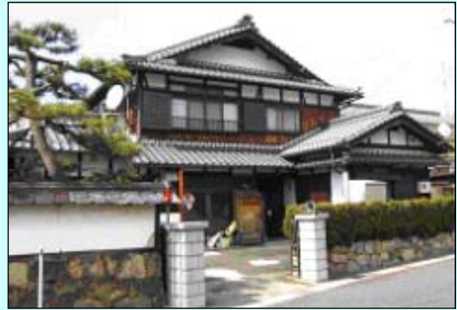
■ 伝統的木造住宅(土壁・真壁)
