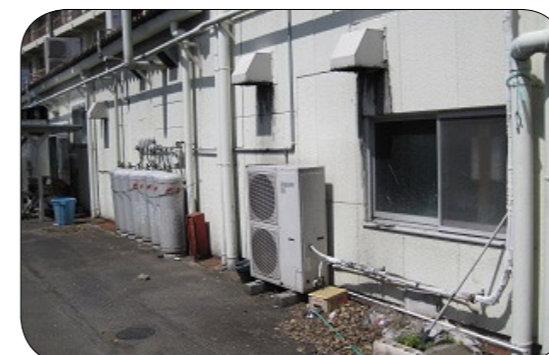
室外環境異常による配管の劣化
