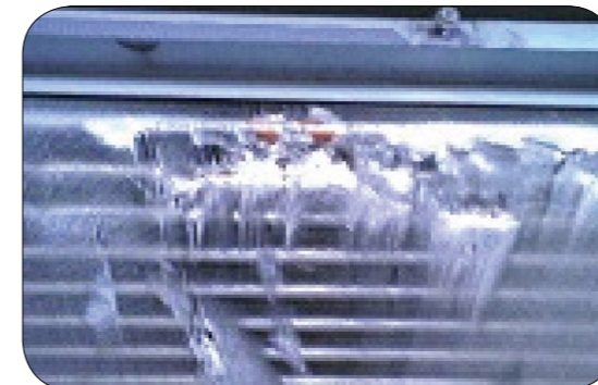
熱交換器表面の損傷
