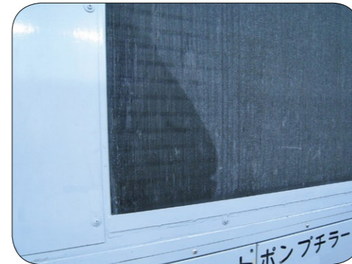
熱交換器の油のにじみ
