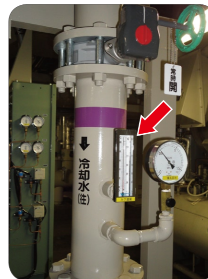
冷却水入口温度計確認
