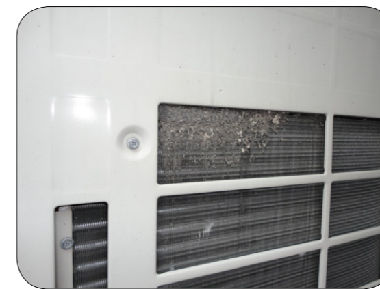
室外機に付着したゴミ
