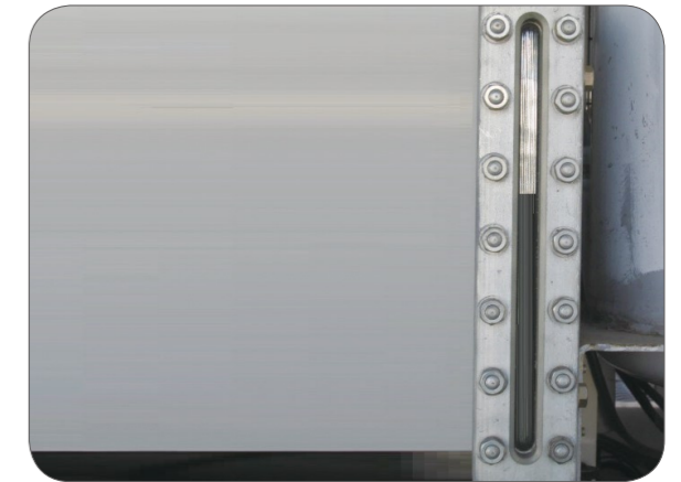
受液器液面計の液面位置
