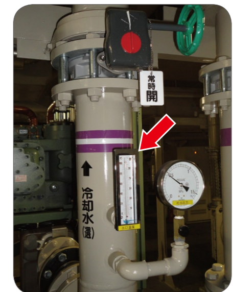
冷却水出口温度計確認
