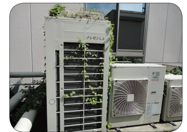
草で覆われた室外機
