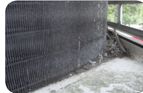
熱交換器下部の腐食
