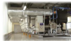
<中央方式冷凍冷蔵機器>
