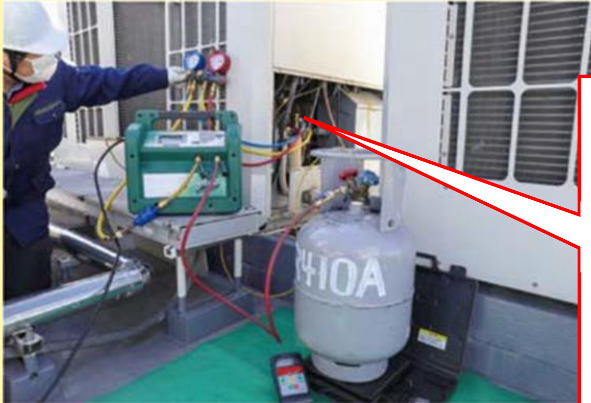
回収ポートからフロン類を回収している様子
