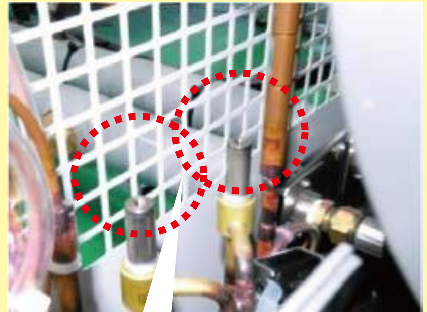
閉鎖している弁のコイルを外す
