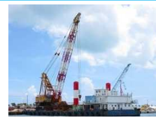
施工クレーン台船
