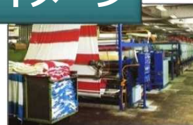
福岡県-江蘇省間のモデル事業で設置した高効率デレンター（染色工程における乾燥設備）等
