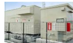
バイオディーゼル非常用発電機
