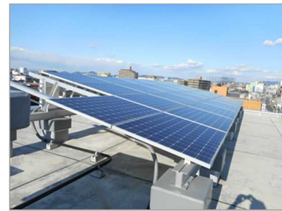
太陽光発電設備
