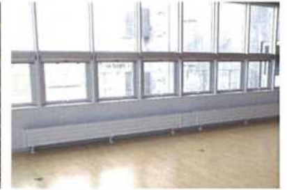
▲温水パネルヒーター【床置型】 (2階 地域防災ホール)
