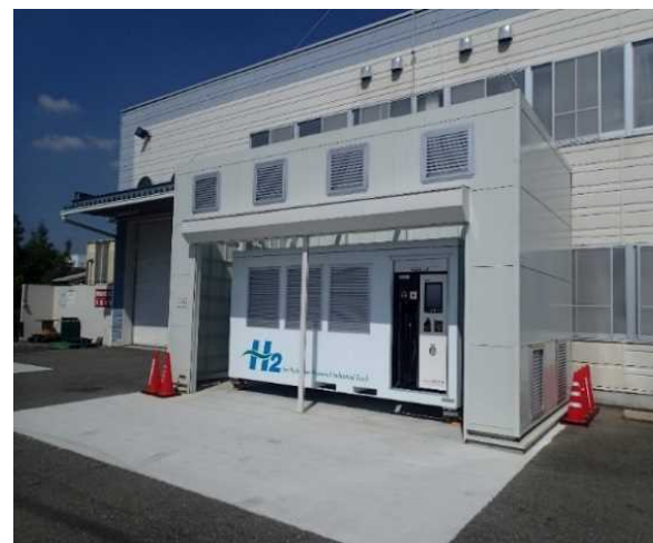
水素ステーション
