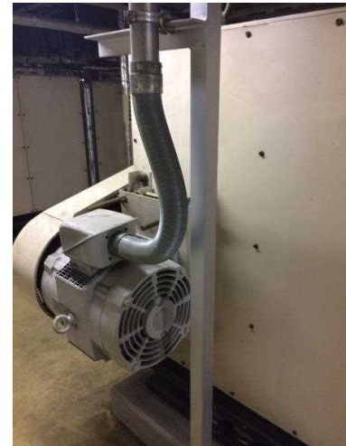
給気ファン(ダクト)
