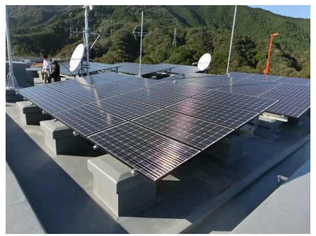
屋上に設置した太陽光発電パネル
