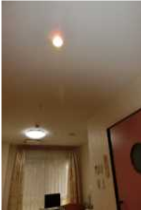
個室のLED照明
