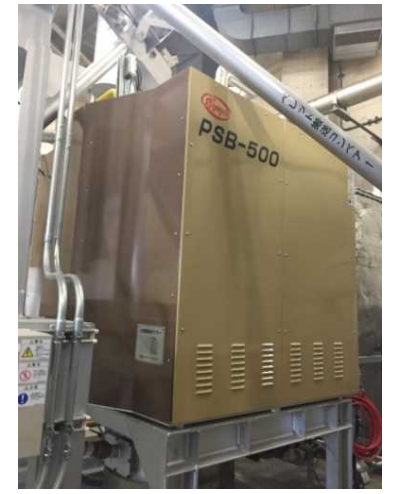
ペレット炊き蒸気ボイラ
