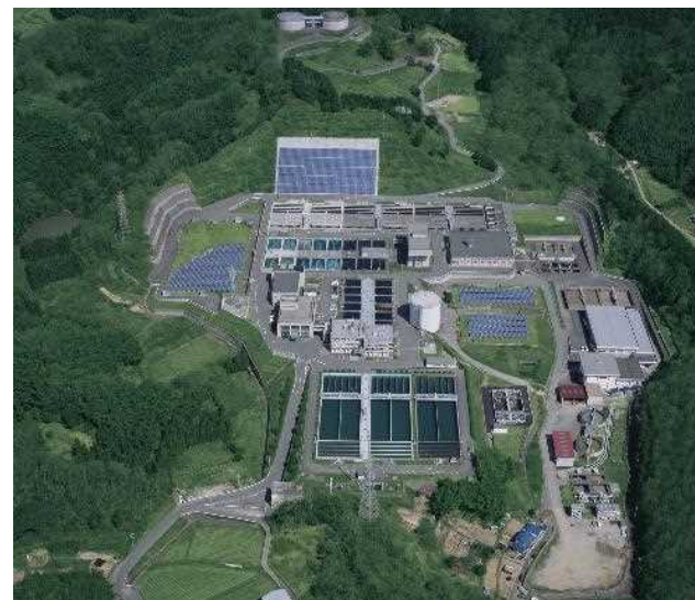
御所浄水場 全景
