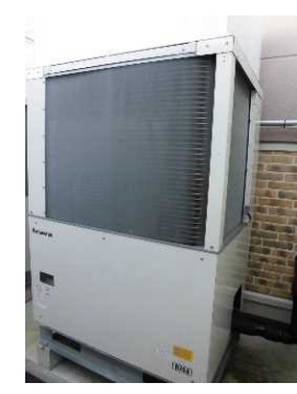
コンデensingユニット アイスクリーム、冷凍食品用のショーケースへ冷熱を供給。
