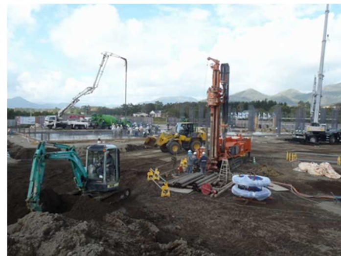
試験井掘削中
