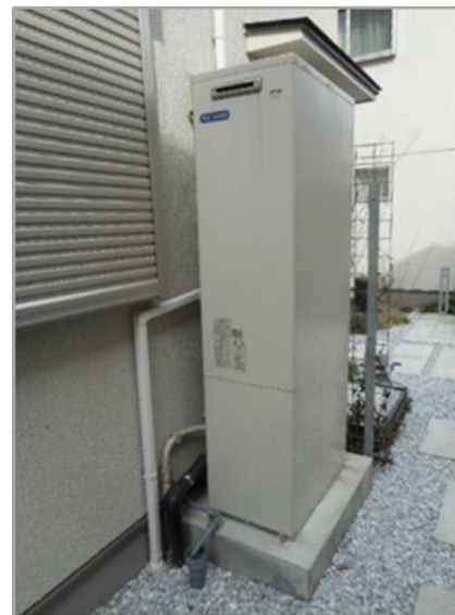
太陽熱利用ガス給湯システム
