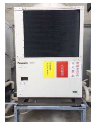
CO 2 冷凍 (室外機)
