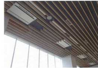
▲天井カセット型エアコン室内機 (2階 地域防災ホール)
