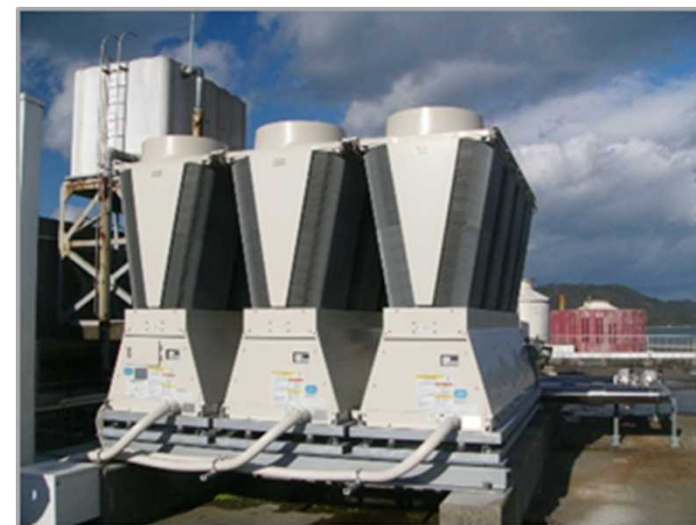
高効率空調設備（チリングユニット）
