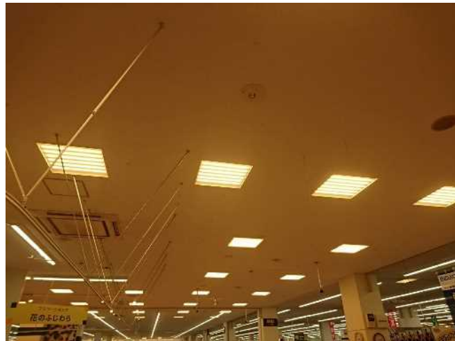
LED照明（室内）
