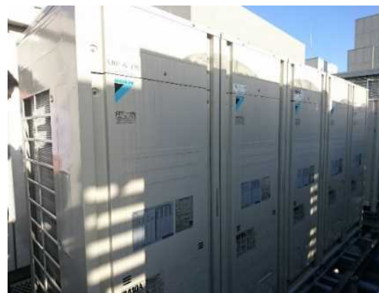
高効率空調(室外機)
