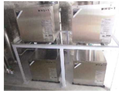
熱利用施設 (ヒートポンプ10kw×5台)
