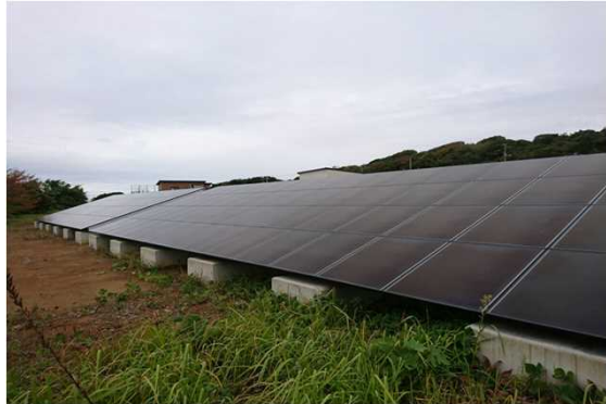
太陽光パネル
