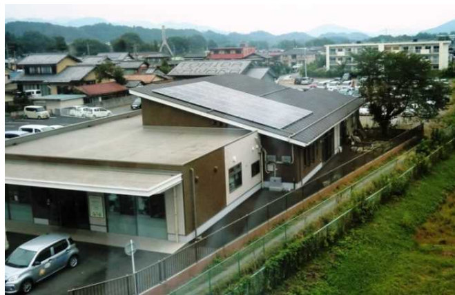
施設全景・太陽光パネル
