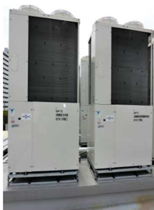
エアコン室外機
