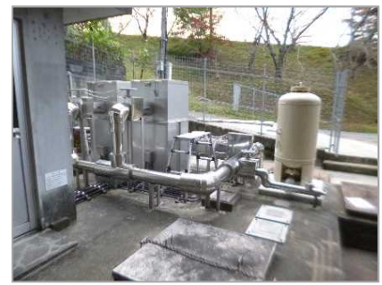
概観 左：加圧ポンプ2基 右：圧力タンク
