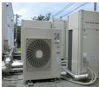
エアコン室外機
