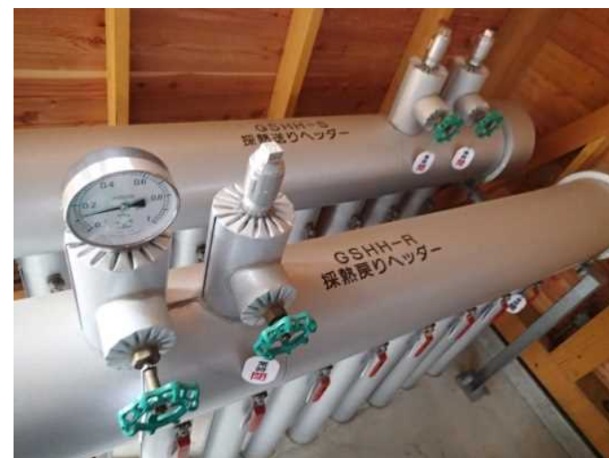
熱交換井パイプ
