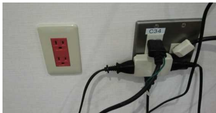
非常用の赤いコンセント
