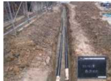
熱輸送施設 (熱輸送管 L=141m)
