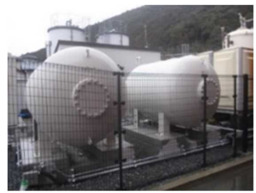
バッファタンク ×2基
