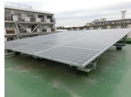
屋上に設置した太陽光発電パネル
