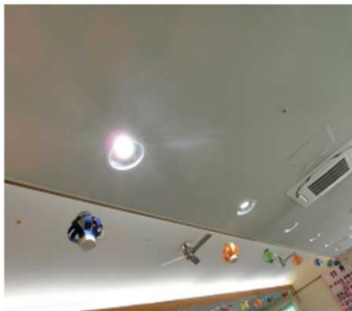
共用部分の照明と空調
