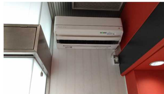
高効率空調設備
