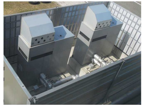
コージェネレーション設備
