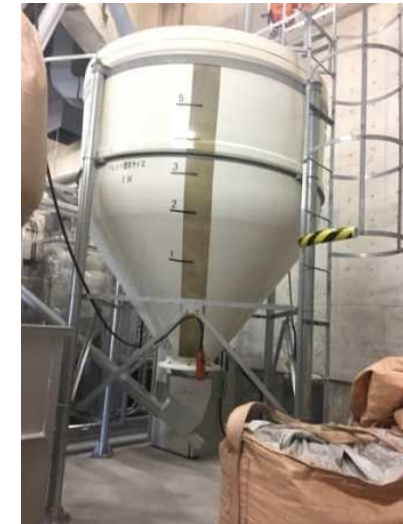
ペレットのストックヤード (サイロ)
