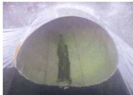
採熱施設 (下水管路内採熱管 L=65m)
