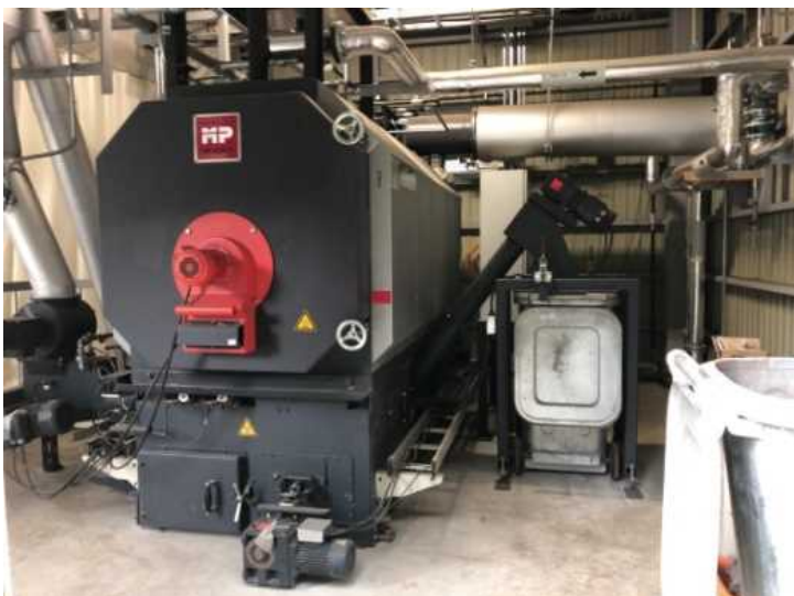
竹の燃焼を可能にしたバイオマスボイラー
