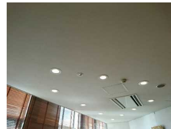
高効率空調(室内機)
