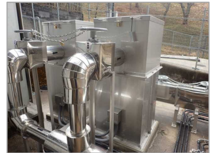
加圧ポンプ 1号(5.5kW)、2号(5.5kW)
