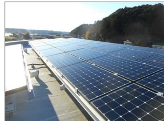
太陽光発電設備
