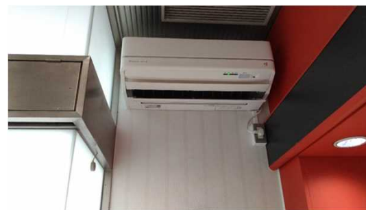
高効率空調設備
