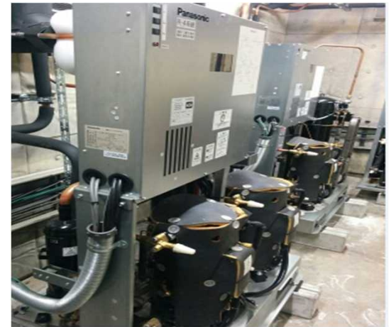
冷凍冷蔵設備
