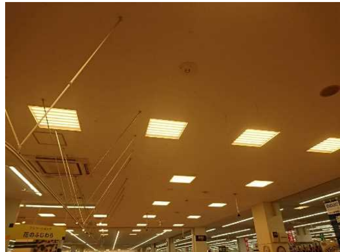
LED照明（室内）
