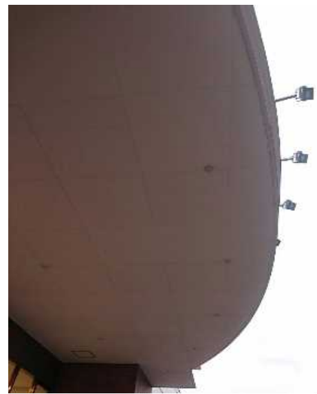
LED照明（室外）
