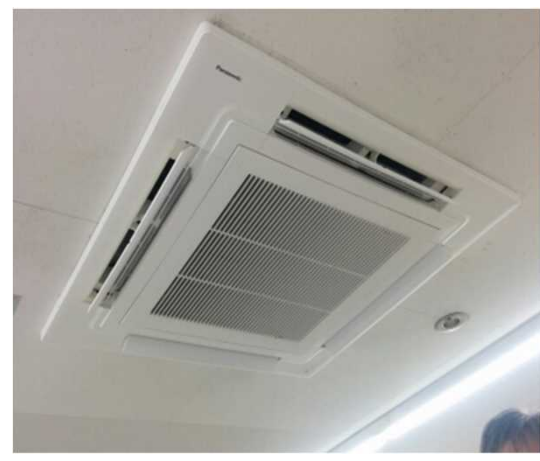
高効率空調設備 (室内機)
