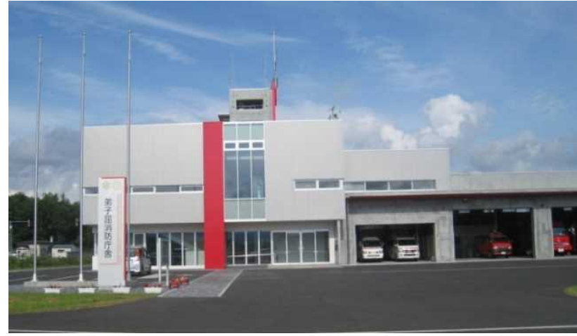
弟子屈消防署 全景
