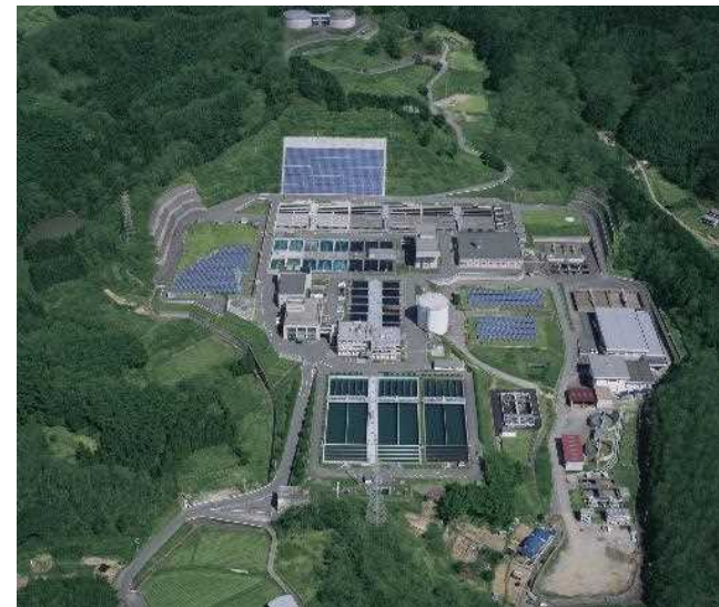
御所浄水場 全景
