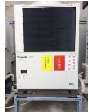
CO2冷凍 (室外機)
