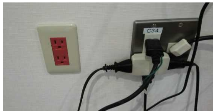
非常用の赤いコンセント
