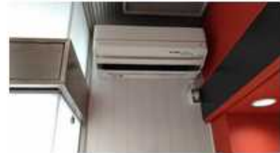
高効率空調設備
