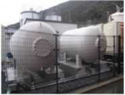
バッファタンク ×2基
