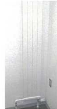
▲温水パネルヒーター 【壁掛型】
