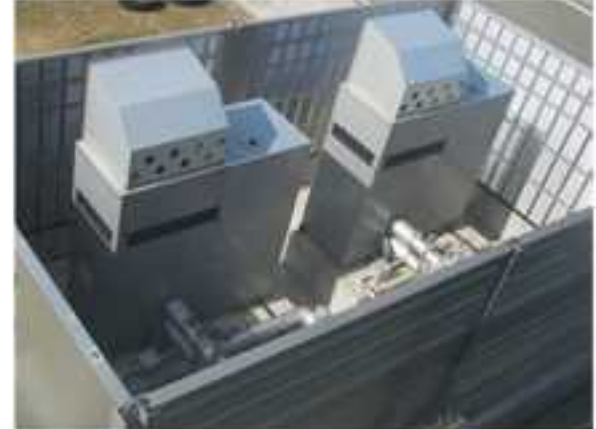
コージェネレーション設備
