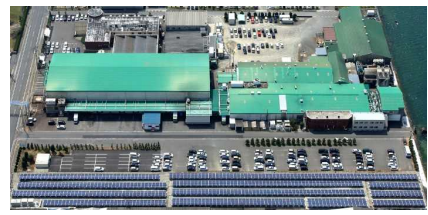
全景。臨海工業団地内に立地している。
