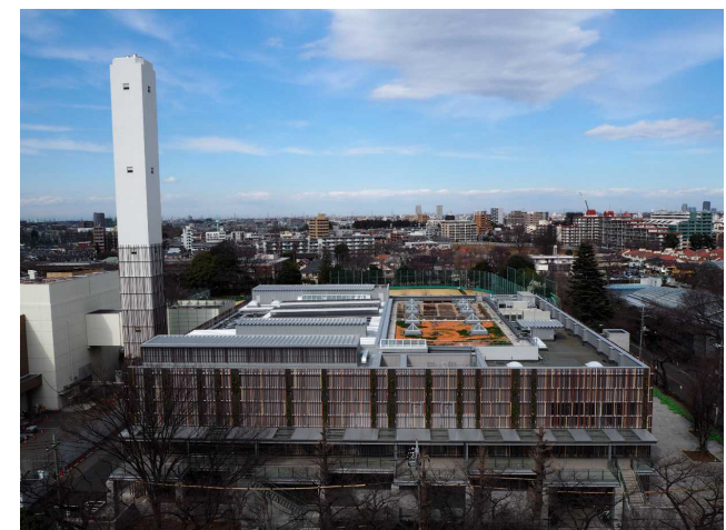
新武蔵野クリーンセンター(廃棄物焼却施設)の外観 (旧クリーンセンター (建替え前の施設) と同一敷地内東側に建設)
