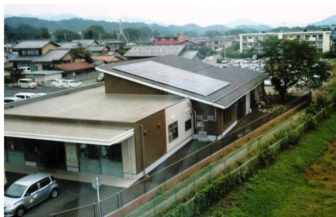
施設全景・太陽光パネル
