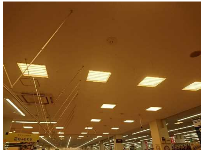
LED照明（室内）
