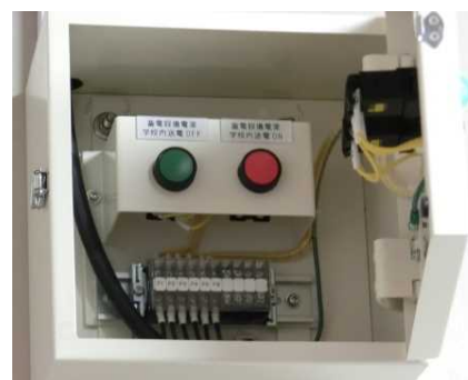
非常用系統切り替え用ボタン (用務員室)
