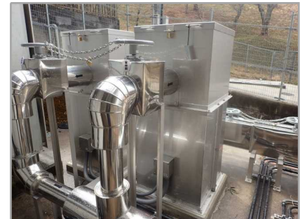
加圧ポンプ 1号(5.5kW), 2号(5.5kW)
