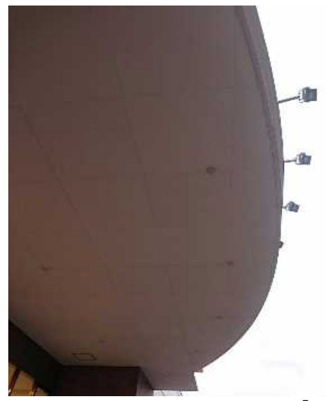
LED照明（室外）
