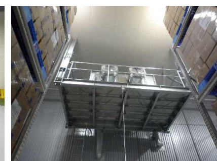
庫内 (ユニットクーラー) 架台上に設置してある。
