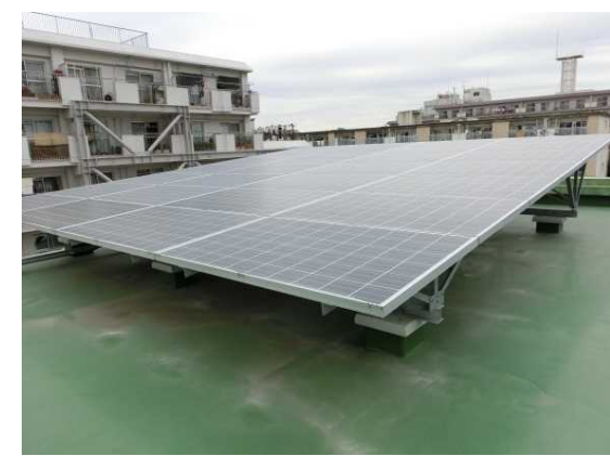
屋上に設置した太陽光発電パネル
