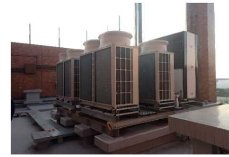
高効率空調設備
