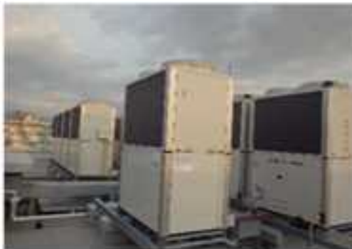
ガスヒートポンプエアコン
