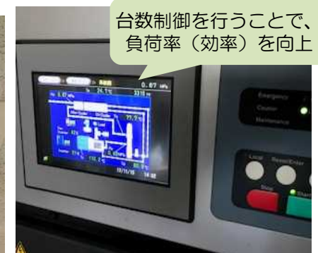
コンプレッサー台数制御装置
