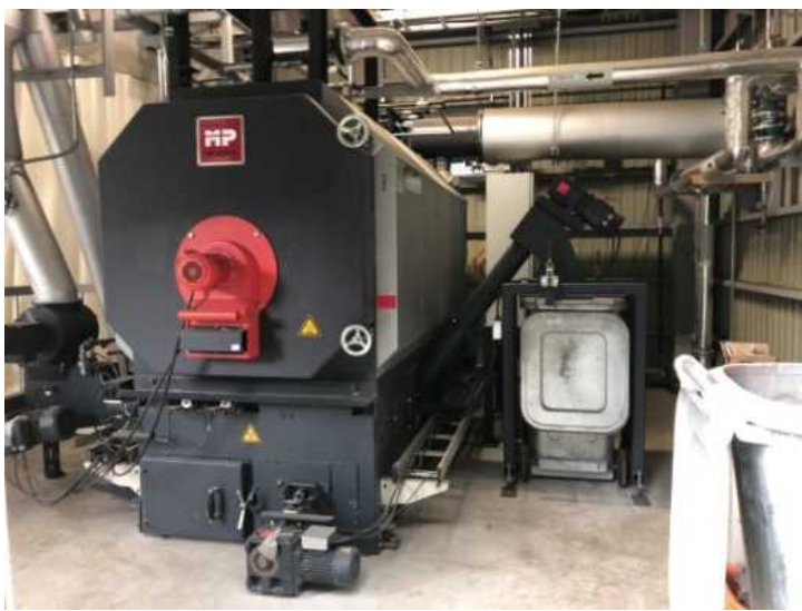
竹の燃焼を可能にしたバイオマスボイラー
