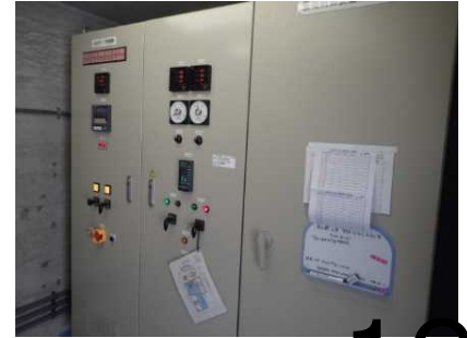
ポンプ制御盤 インバータ機器(5.5kW)
