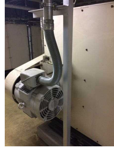
給気ファン(ダクト)
