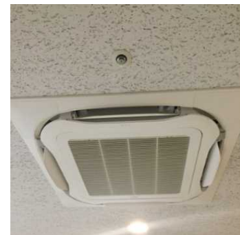
高効率空調(室内機)
