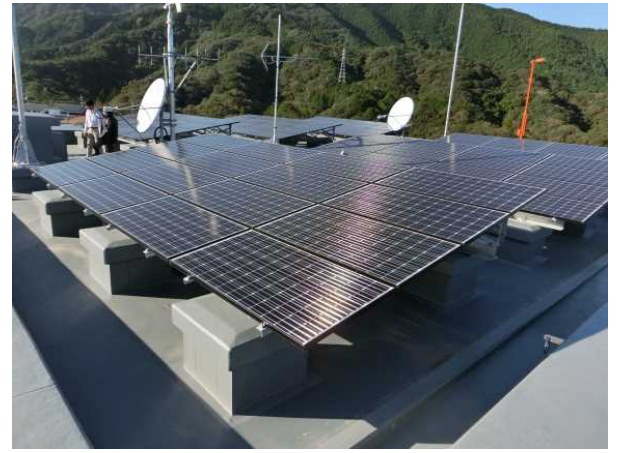
屋上に設置した太陽光発電パネル
