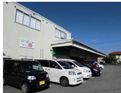
全景。 市街地に立地する2階建の建物。1階部分が倉庫、2階が事務所。
