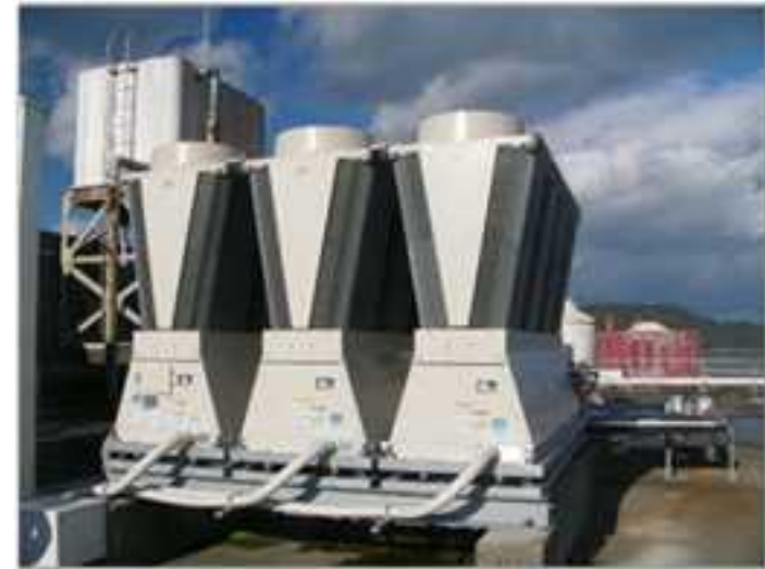
高効率空調設備（チリングユニット）
