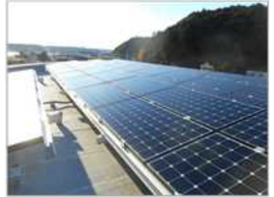
太陽光発電設備
