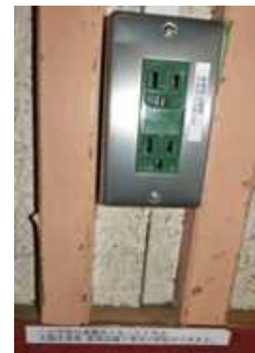
非常用の緑色コンセント (体育館)
