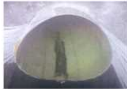
採熱施設 (下水管路内採熱管 L=65m)
