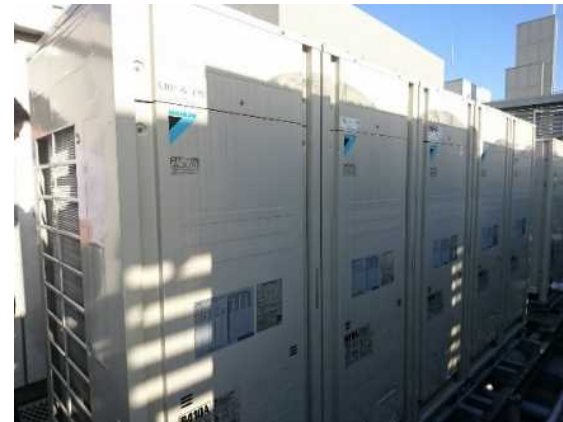
高効率空調(室外機)
