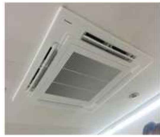
高効率空調設備 (室内機)
