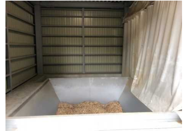
竹チップボイラのストックヤード
