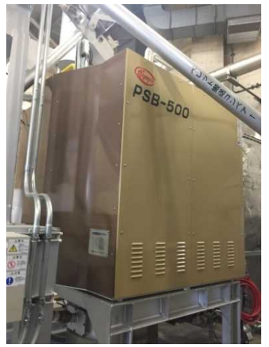
ペレット炊き蒸気ボイラ
