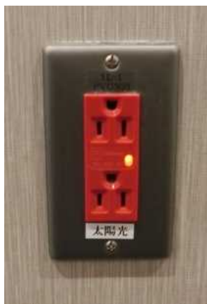
非常用の医療用LED付 コンセント（有電圧時点灯）
