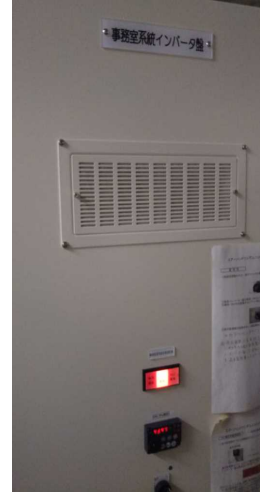
インバータ制御装置
