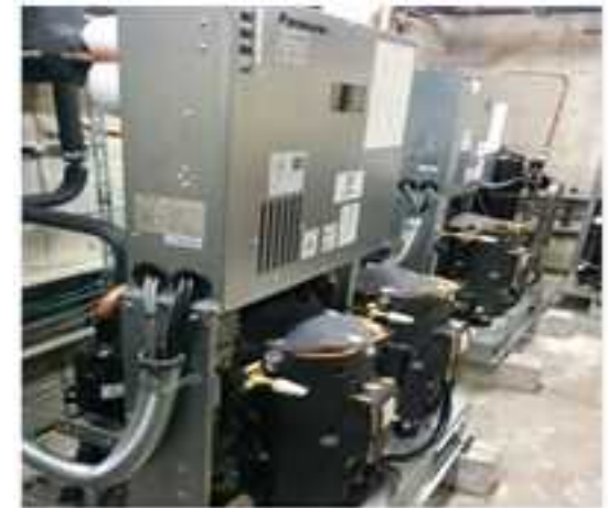
冷凍冷蔵設備
