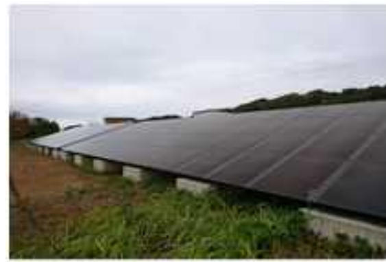
太陽光パネル
