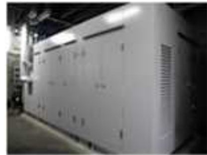
冷凍ユニット。機械室での設置状況。
