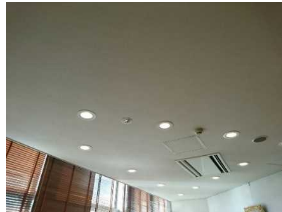
高効率空調(室内機)
