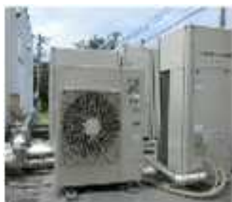
エアコン室外機
