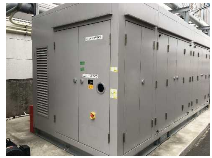
冷凍ユニット アンモニア冷媒圧縮機などの機器類が格納されている。
