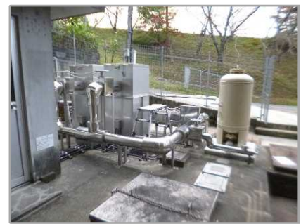
概観 左：加圧ポンプ2基 右：圧力タンク
