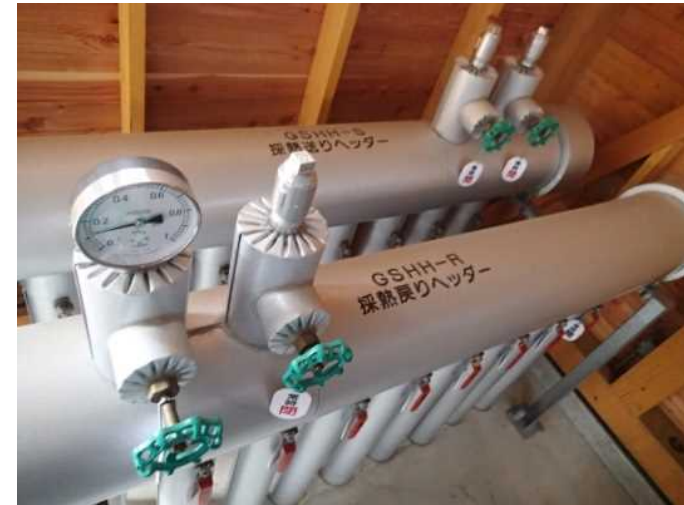
熱交換井パイプ
