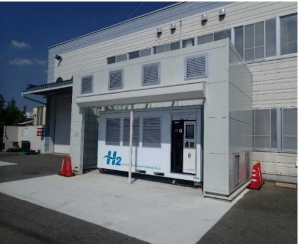
水素ステーション
