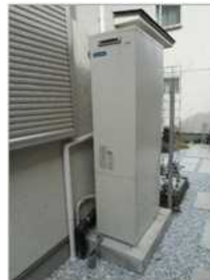
太陽熱利用ガス給湯システム
