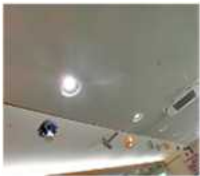
共用部分の照明と空調
