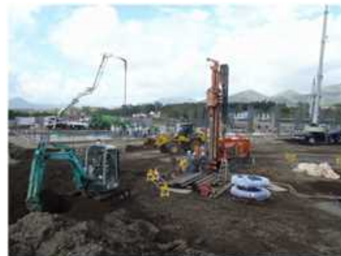
試験井掘削中
