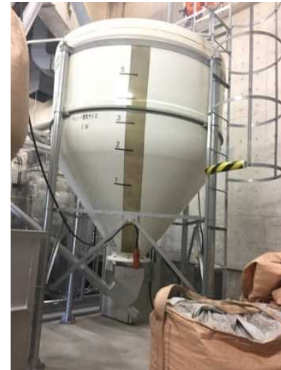
ペレットのストックヤード (サイロ)
