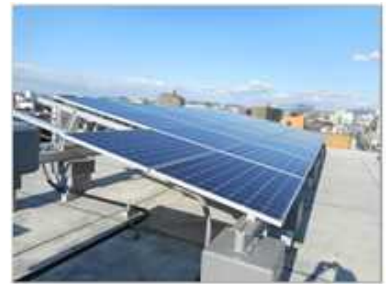
太陽光発電設備
