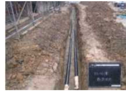
熱輸送施設 (熱輸送管 L=141m)
