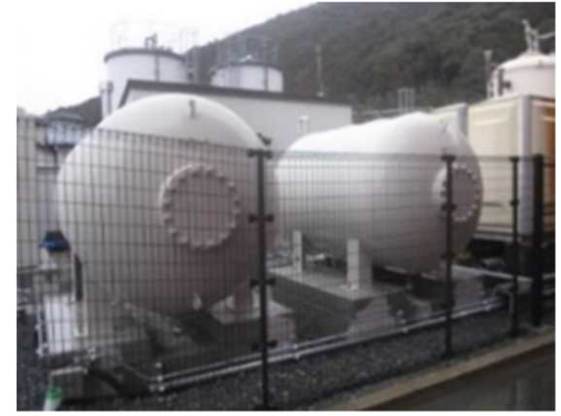
バッファタンク ×2基
