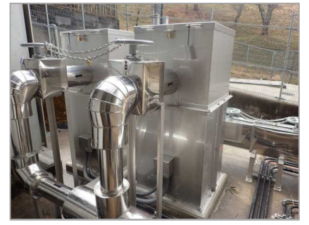
加圧ポンプ 1号(5.5kW), 2号(5.5kW)
