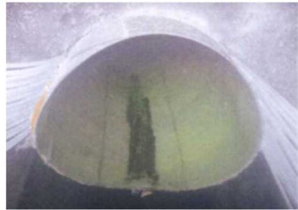
採熱施設 (下水管路内採熱管 L=65m)
