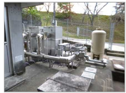
概観 左：加圧ポンプ2基 右：圧力タンク
