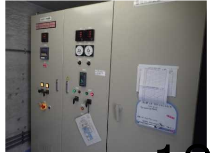
ポンプ制御盤 インバータ機器(5.5kW)
