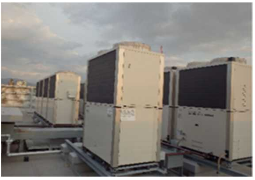
ガスヒートポンプエアコン
