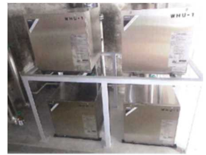
熱利用施設 (ヒートポンプ10kw×5台)
