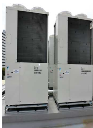
エアコン室外機
