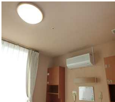
居室の照明と空調
