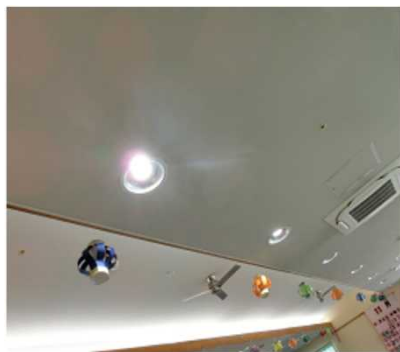
共用部分の照明と空調
