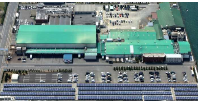
全景。臨海工業団地内に立地している。
