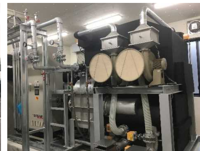
空気冷媒冷凍ユニット。 超低温冷凍庫に隣接する屋内に設置されている。
