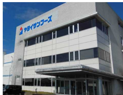
全景 市街地内に立地している。
