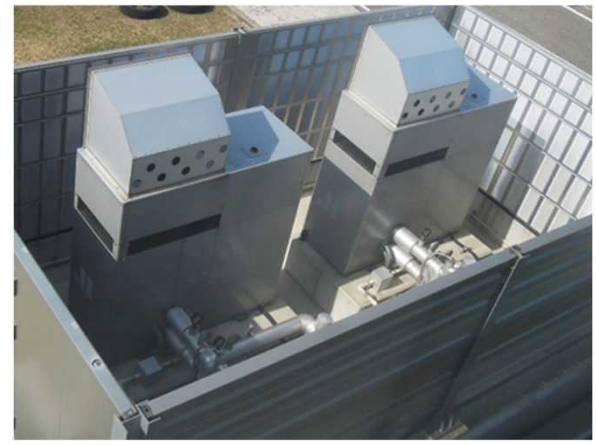
コージェネレーション設備
