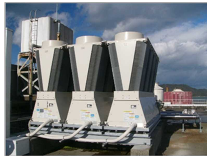
高効率空調設備（チリングユニット）
