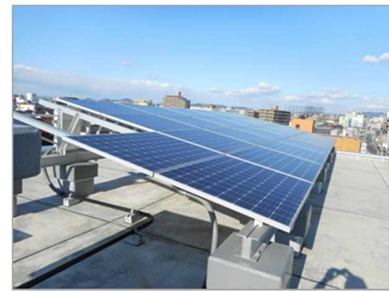
太陽光発電設備
