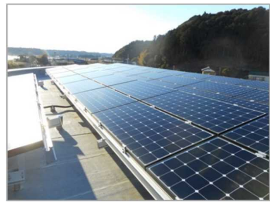
太陽光発電設備
