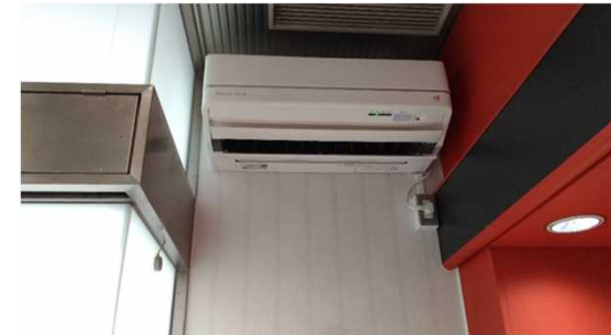
高効率空調設備
