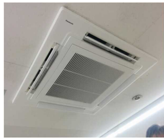
高効率空調設備 (室内機)
