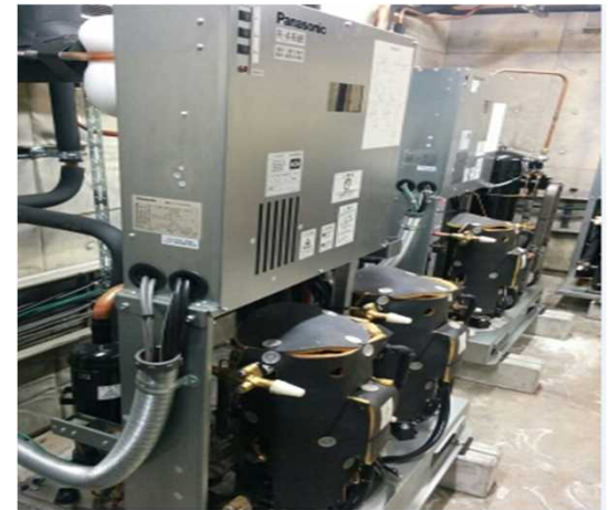
冷凍冷蔵設備
