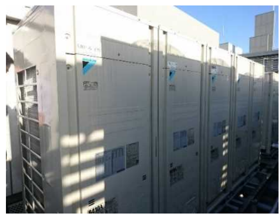
高効率空調(室外機)
