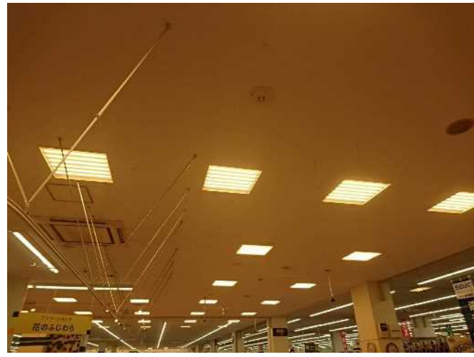
LED照明（室内）
