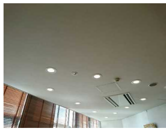
高効率空調(室内機)
