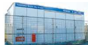
①蓄電装置
