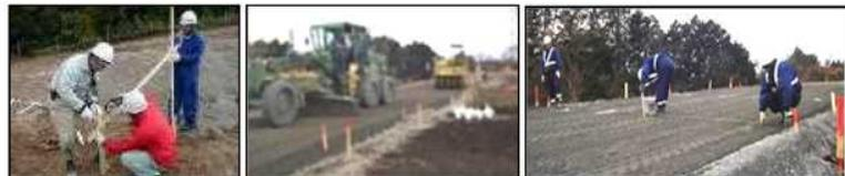
設計図に合わせ 丁張り設置      丁張りに合わせて施工      検測と施工を繰返して整形
