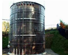
貯湯槽（保温前）
