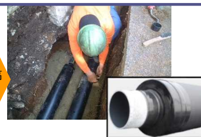
温泉の供給配管を高断熱配管に更新
