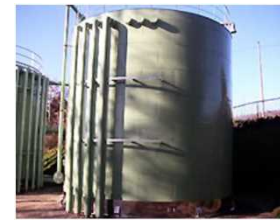
貯湯槽（保温後）
