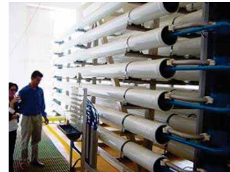
Desalinization plant (Tunisia)
