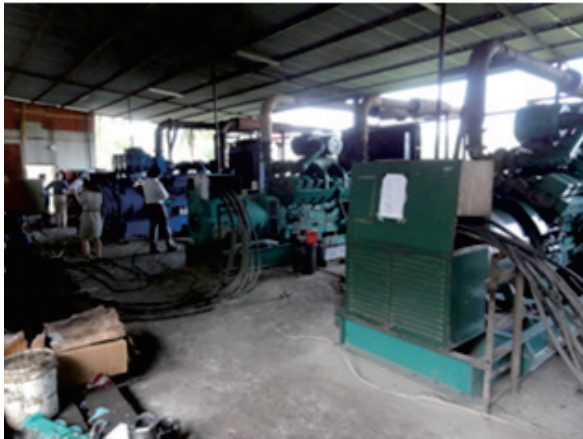
PLN ENGINE (TelukDalam)
