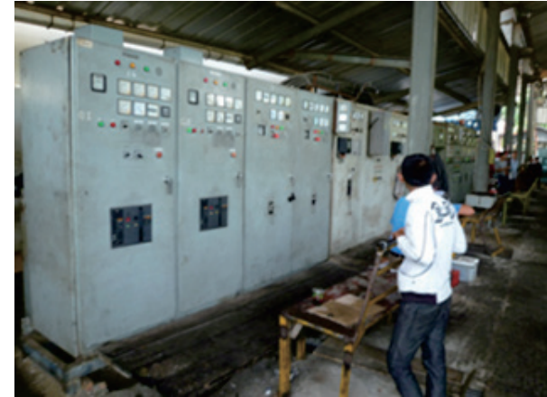
POWER PANEL (Gunungsitoli)
