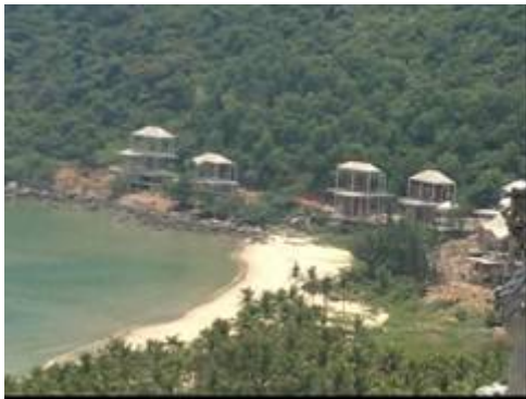
(建設中のヴィラ)
