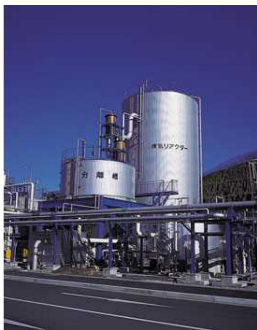
図 3.6.1 流動床高負荷嫌気性排水処理装置
