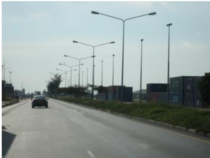
図 50 レムチャバン港周辺道路の照明
