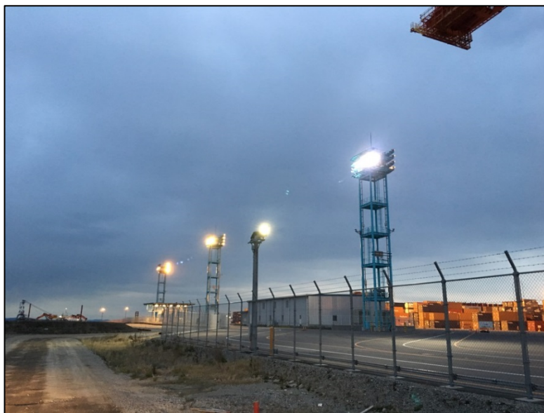
図 37 横浜港コンテナヤードの LED 照明
