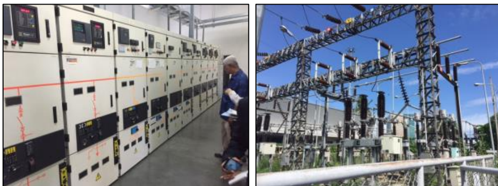
図 51 バンコク港の現在の受変電設備
