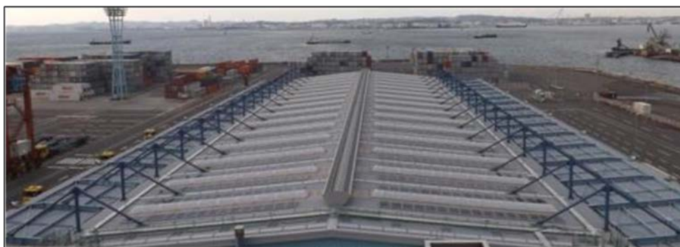
図 19 横浜港南本牧ふ頭 CFS の太陽光パネル
