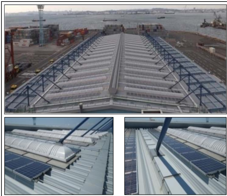
図 63 横浜港南本牧ふ頭 CFS の太陽光パネル カマボコ型の明りとりが備えられている
