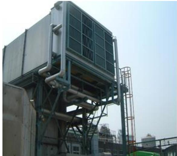
図-3.7 ガスタービン吸気冷却器取り付け状況
