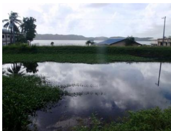
写真 1.2.2.1 第3（最終）沈殿池
