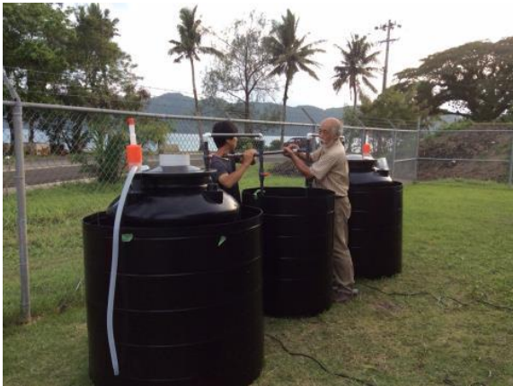
写真 4.4.3.1 プラント組立て
